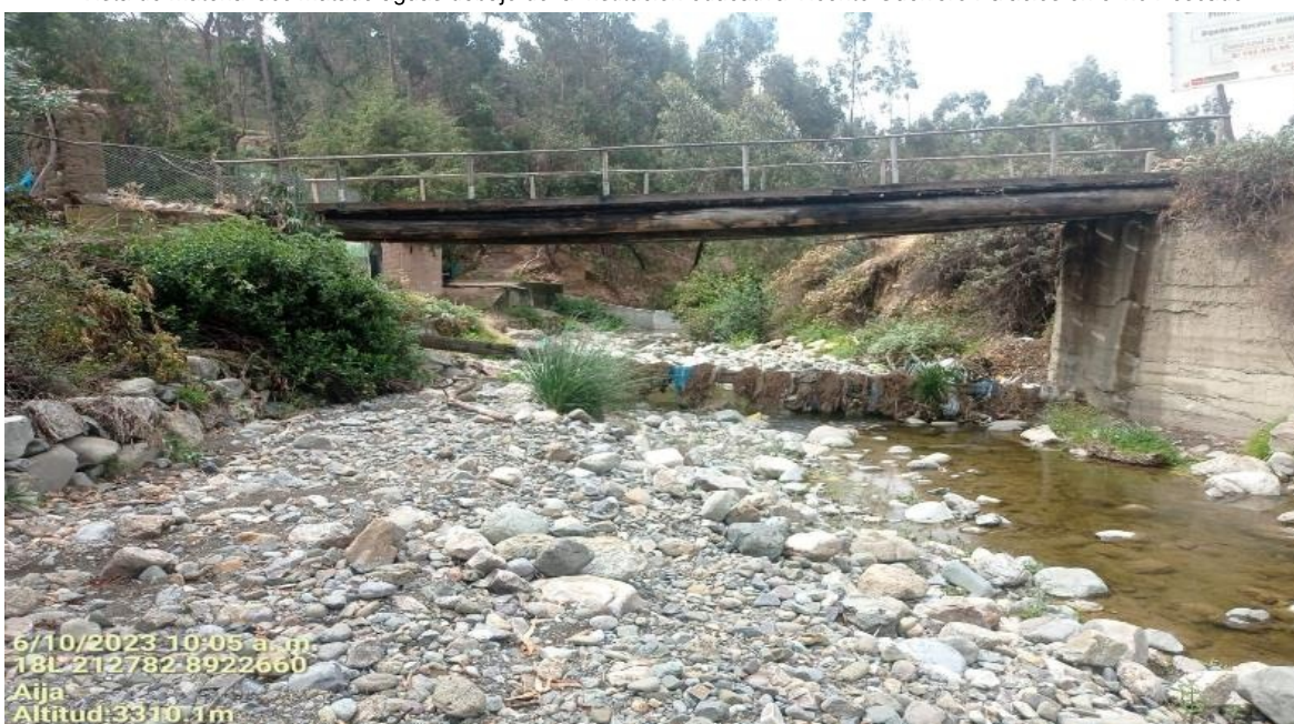
Vista de material acolmatado aguas arriba del puente y bocatoma en el rio Pescado
